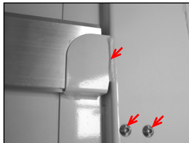
Usadni džep na ugaonom stubu
