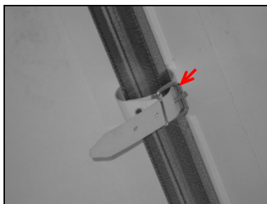
Kaiša za zatezanje na poprečnom arnju
