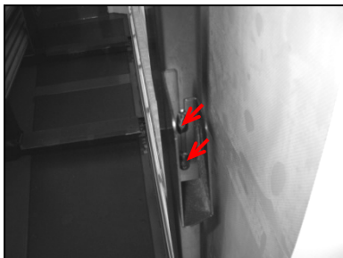
Usadni džep na srednjem stubu
