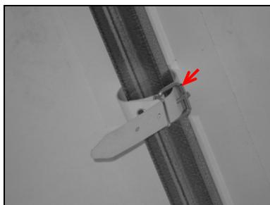
Courroie de tension sur arceau
