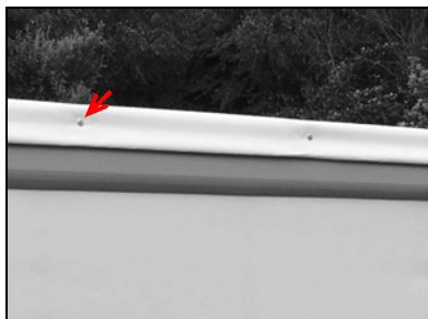
Покривало за покрива (нитове)
